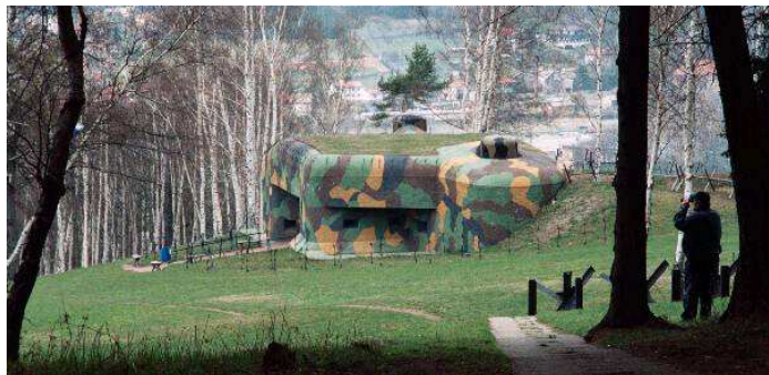
Rudolf Frič a Československá armáda: Březinka, 1937, železobeton a pancéřová ocel. Pięknie utrzymany schron piechoty nad doliną Metui
